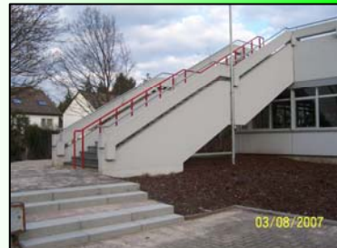
Der Außenbereich mit neuen Treppen, Pflaster und Fassadenanstrich.
